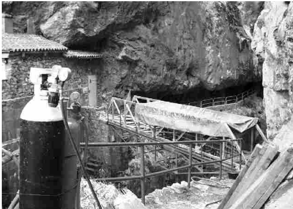
Puente de la Presa en Obras
