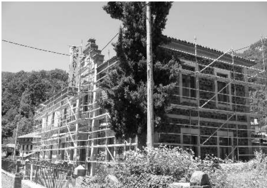
Escuela de Soto durante las actuales obras. Foto: Lorenzo Sevilla.
