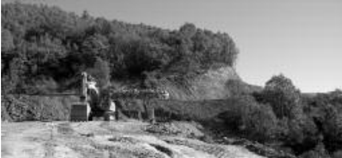
Obras en Picones. Foto: Salvador González (Archivo).
