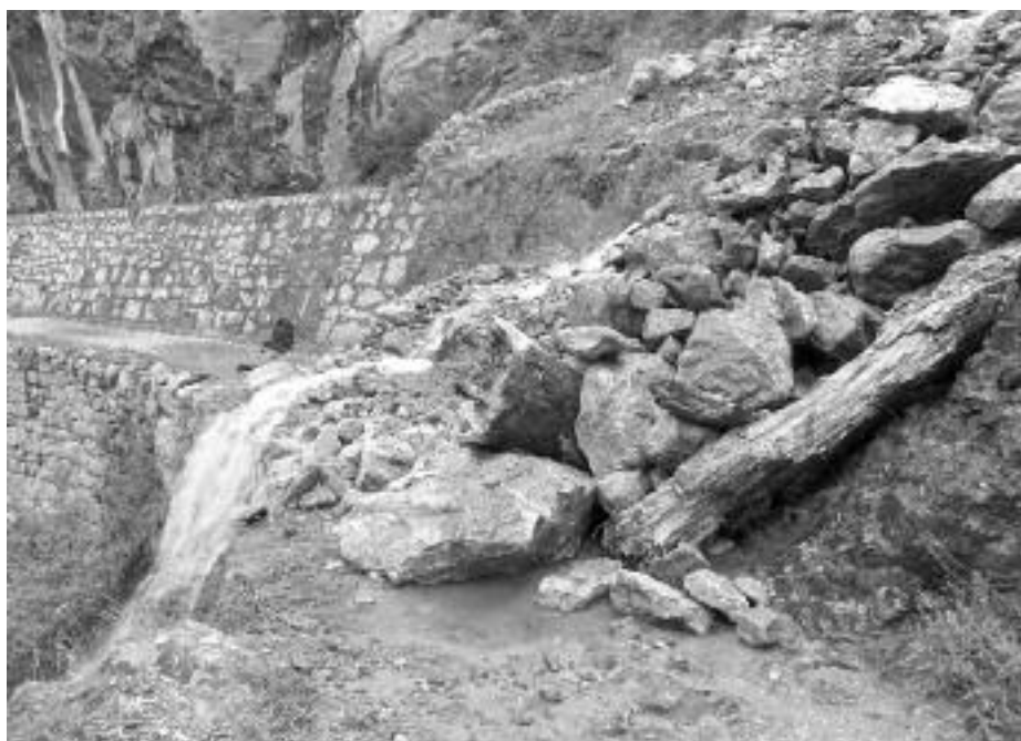
Derrumbe de la Canal de la Teja. Foto: M. Fernández.
