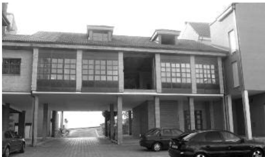
Estado de la "nueva" sede de la Mancomunidad.
