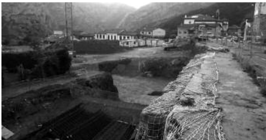
Estado de las obras. Arriba Posada de Valdeón. Abajo Oseja de Sajambre.
