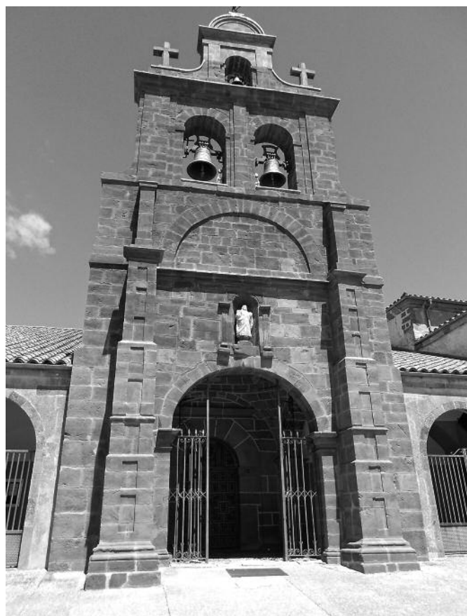
La fachada antes y después de la limpieza.
