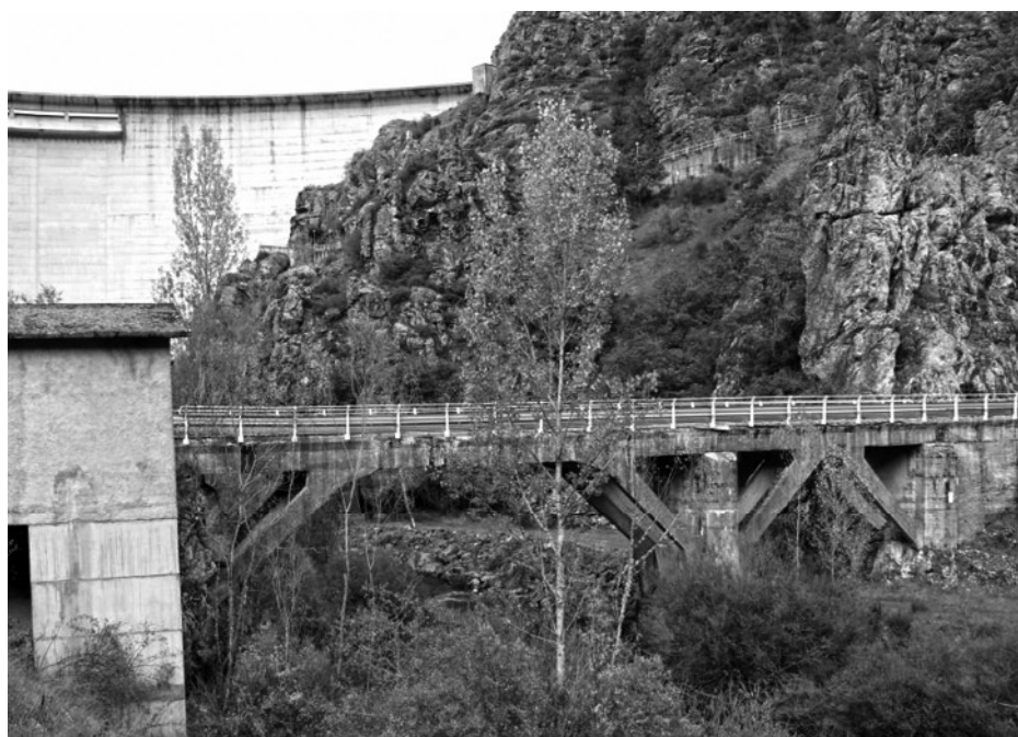
Puente actual de Remolina.
